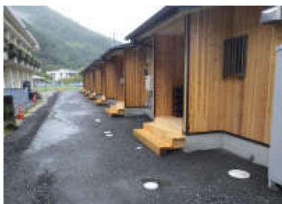
明間地区応急仮設住宅(建設型)
