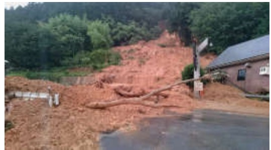
国道 197 号被害（高野子）
