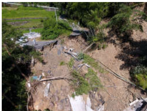
市道・林道被害（遊子谷南平）
