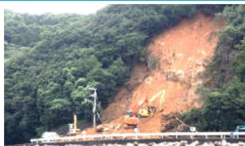
国道 378 号被害（有網代）
