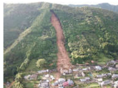
土砂崩壊（明間四道地区）
