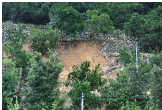
樹園地被害（狩浜）
