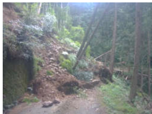
市道被害（窪野地区）
