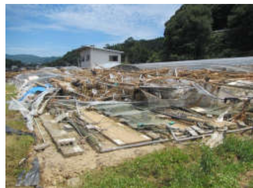
農業用ハウス被害（三島町）
