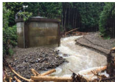
宇和上水道下川配水池付近
