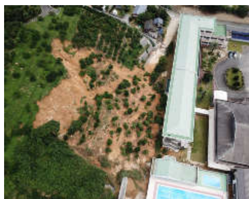
急傾斜地の崩壊（俵津：下ノ谷地区）
