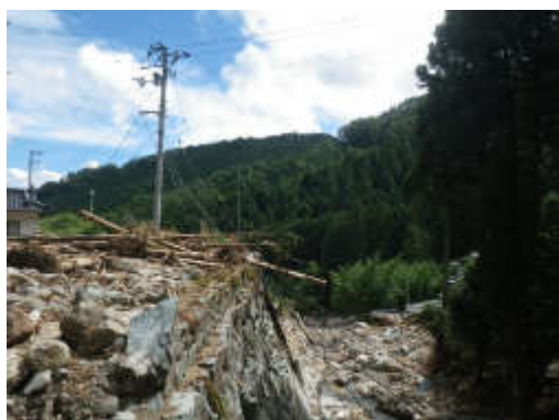
野村町深山 電気・通信ケーブル被害
