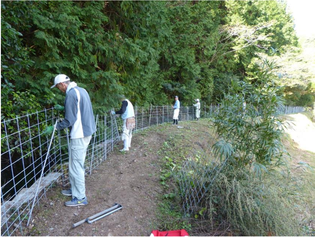
有害鳥獣用防護柵設置
