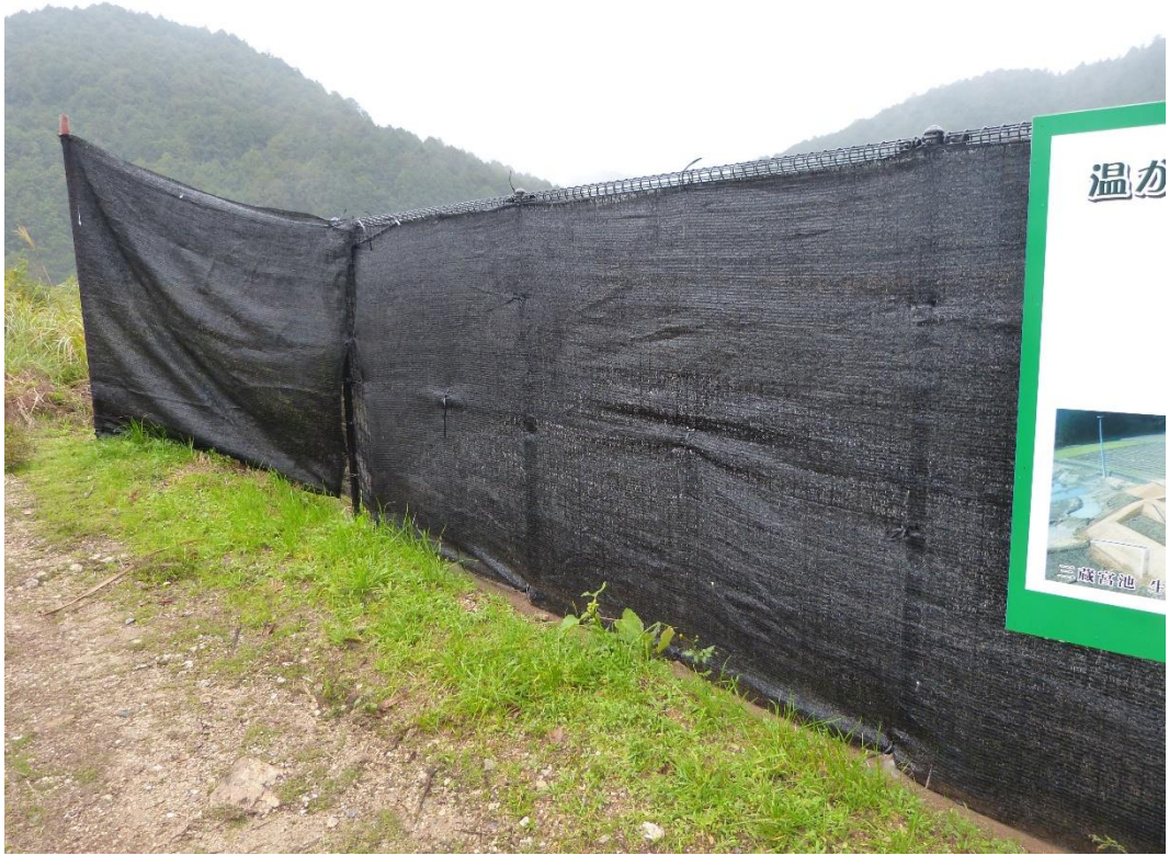
平成 29 年度 寒冷紗用防護柵設置 (宇和町内のため池②)
